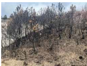
海岸防災林の焼損状況 (岩手県大船渡市 合足地区)
