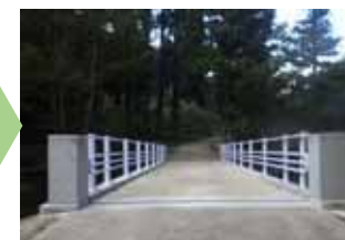
老朽化した橋梁の 断面修復、高欄取替 等による機能強化・ 長寿命化 （福井県大野市）
