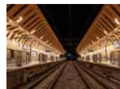
駅舎(東京都品川区)
