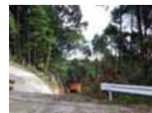
森林作業道の開設
