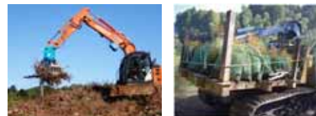
作業の機械化（一貫作業）
