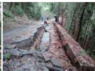
石川県能登半島における災害 (左：地震、大雨による崩壊斜面からの土砂流出（珠洲市） 右：地震による林道災害（輪島市）)
