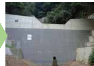
既存ダムをかさ上げ・ 増厚することにより 機能強化・長寿命化 （兵庫県神戸市）
