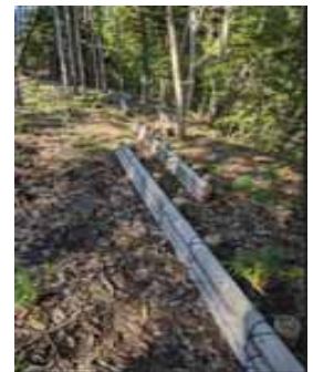
土壌流出防止柵 (放射性物質の移動抑制対策)
