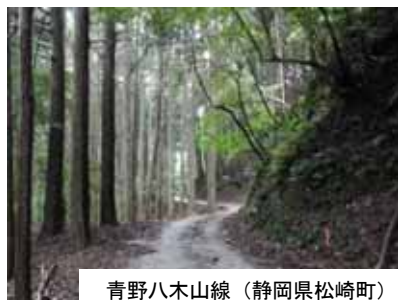
青野八木山線（静岡県松崎町）
