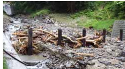
長野県下伊那郡天龍村 令和5年梅雨前線豪雨において、 流木止工が流木等を捕捉
